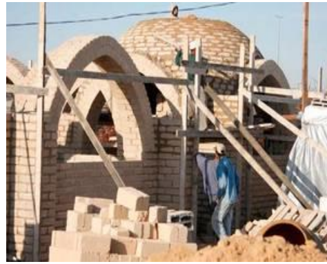
شكل رقم (2) - البناء باللبن الطيني
