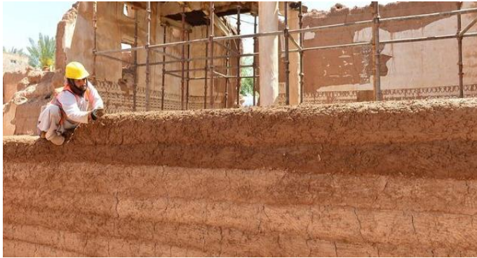
شكل رقم (3) - على اليمين البناء بالمدماميك الطينية ، الشمال البناء بالتراب المضغوط
