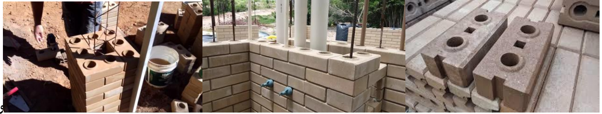
شكل رقم (4) - البناء بالطوب المحسن (طوب الليغو)
